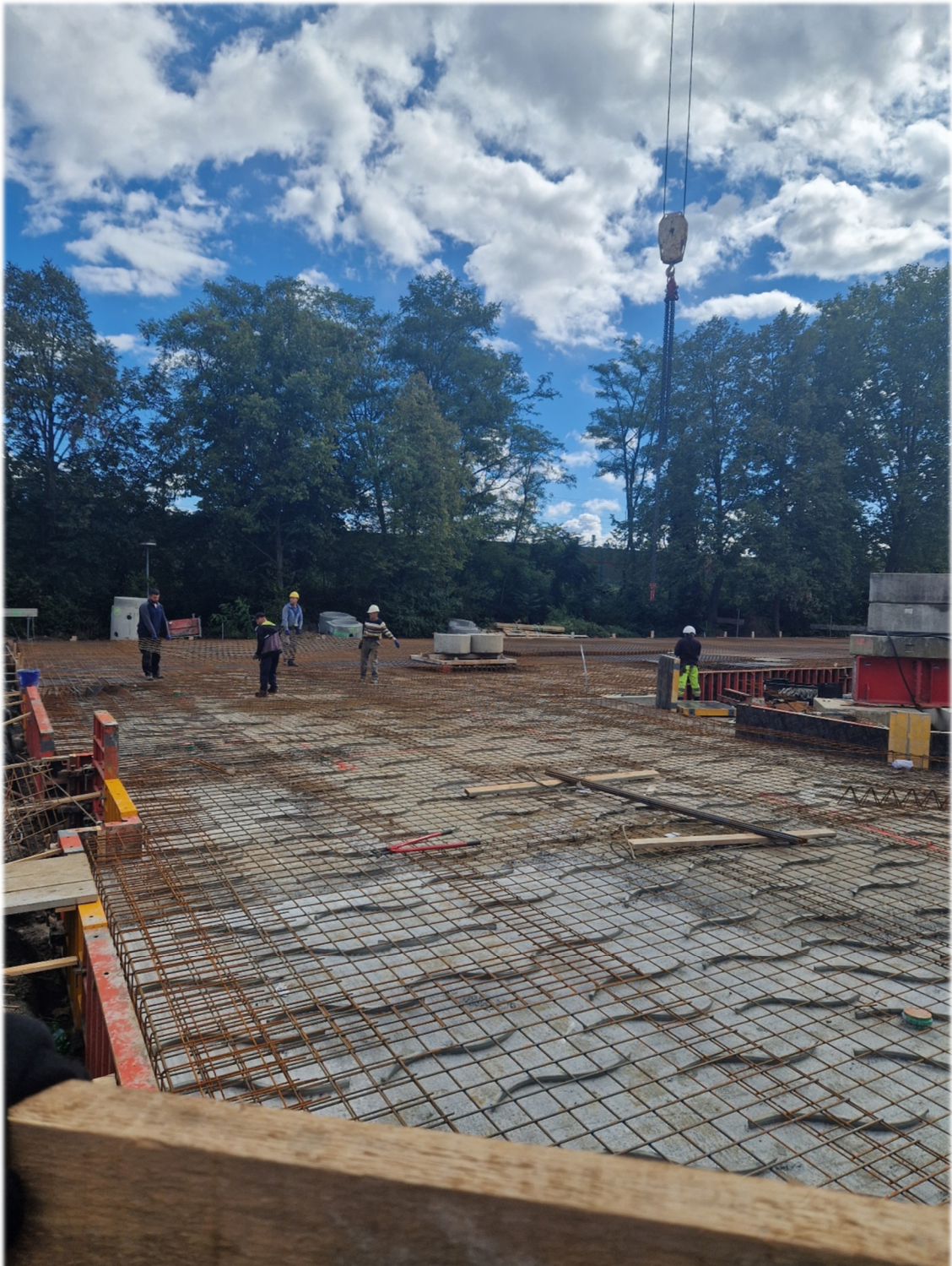
Bewehrung der Bodenplatte des Gebäudes
