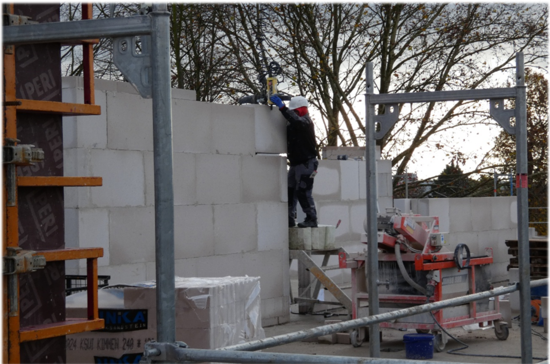
Schalungs- und Maurerarbeiten im Erdgeschoss
