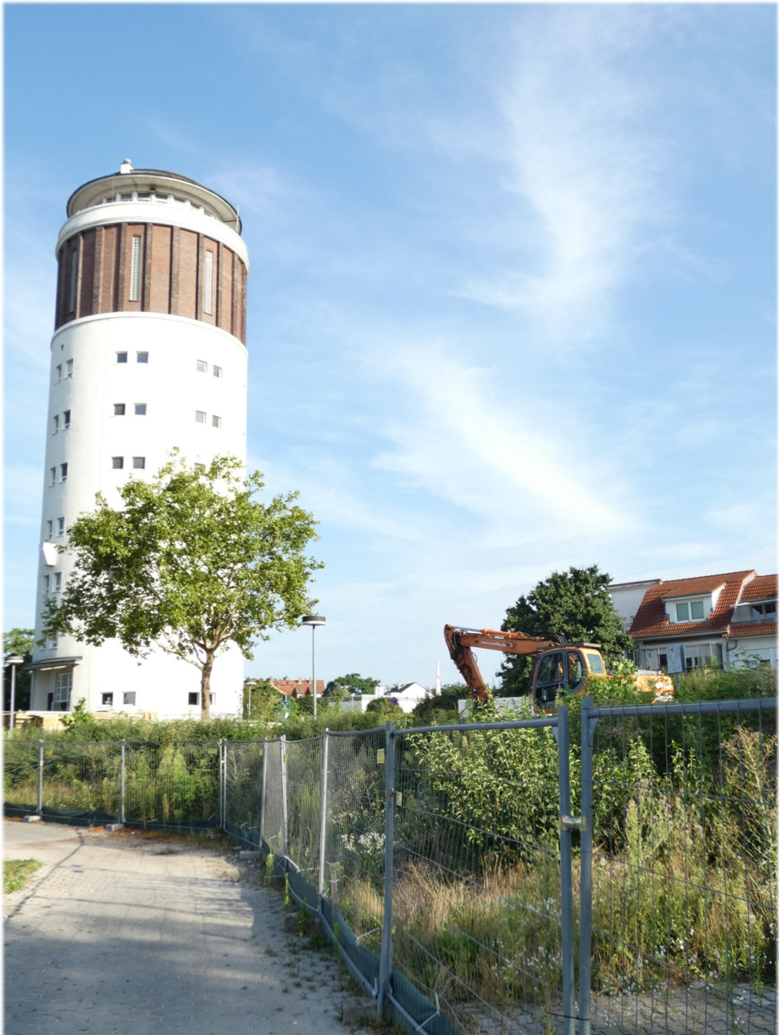
Beginn der Rodungsarbeiten
