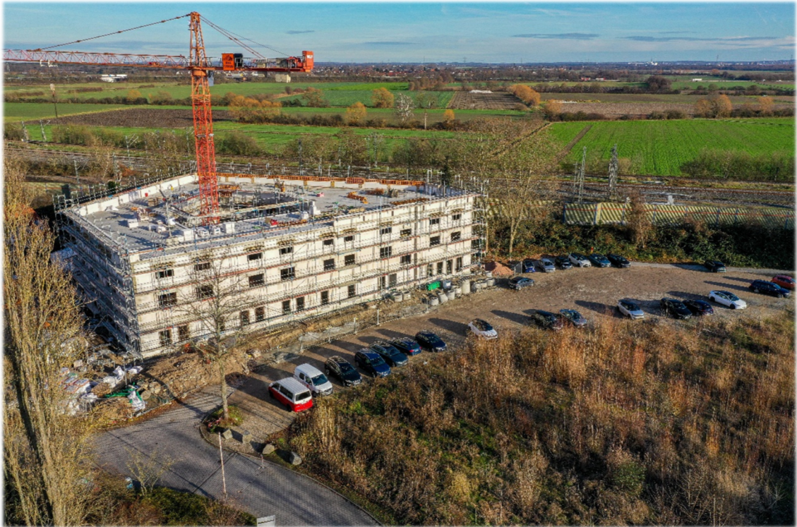
Luftbild des Rohbaus
