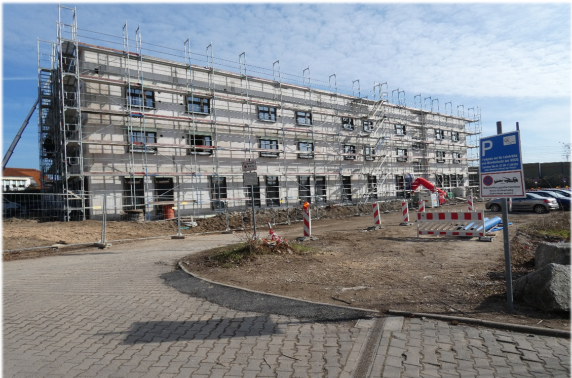
Stand nach Beendigung der Rohbauarbeiten
