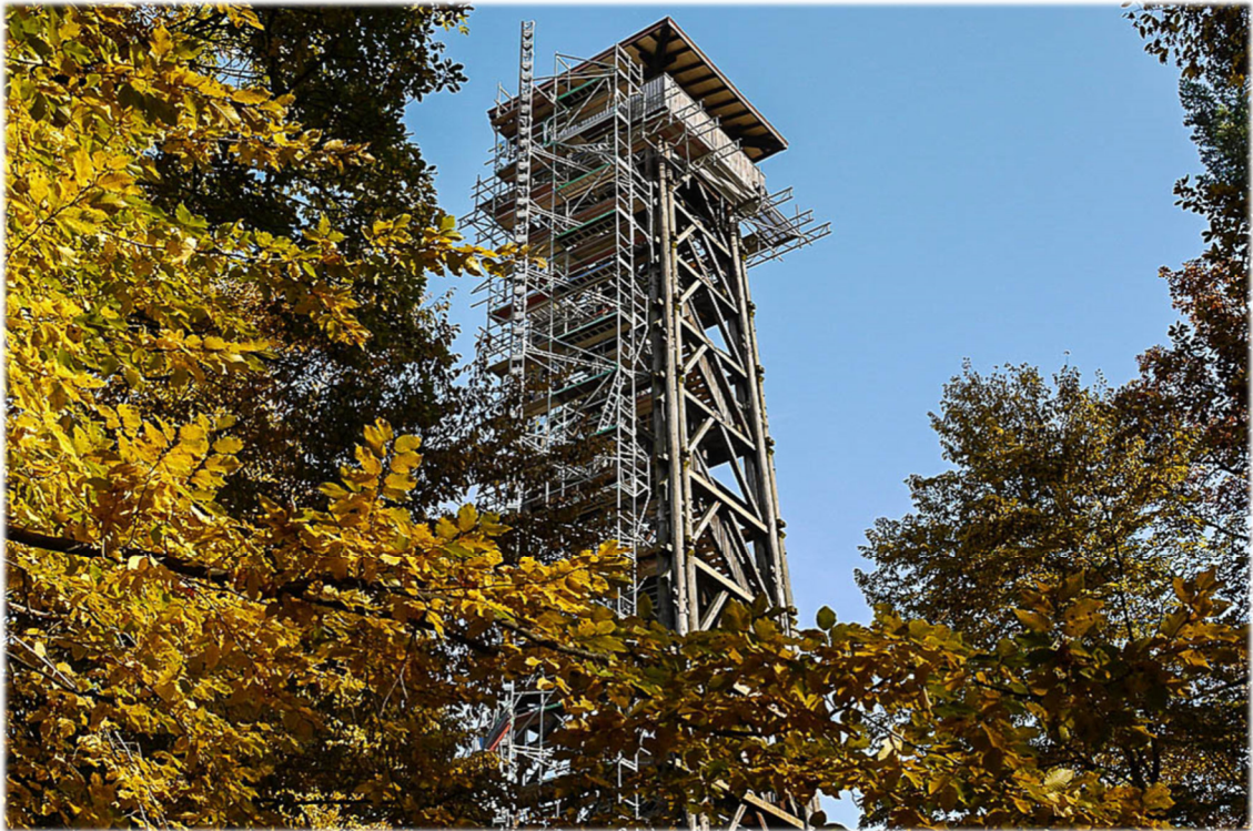
Gerüstbau Paul GmbH: Goetheturm, Frankfurt
