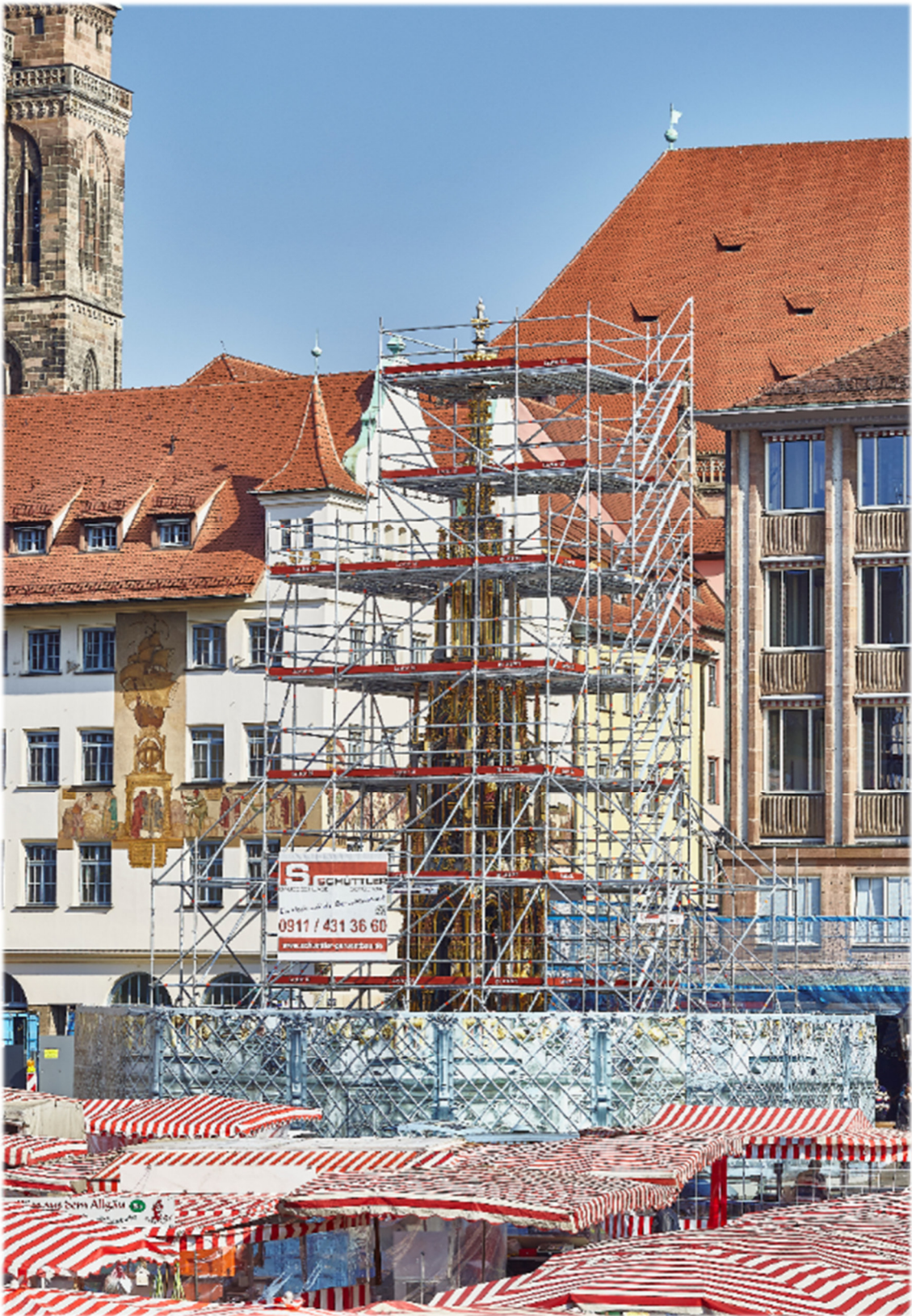
Schüttler Gerüstbau GmbH: Der Schöne Brunnen, Nürnberg
