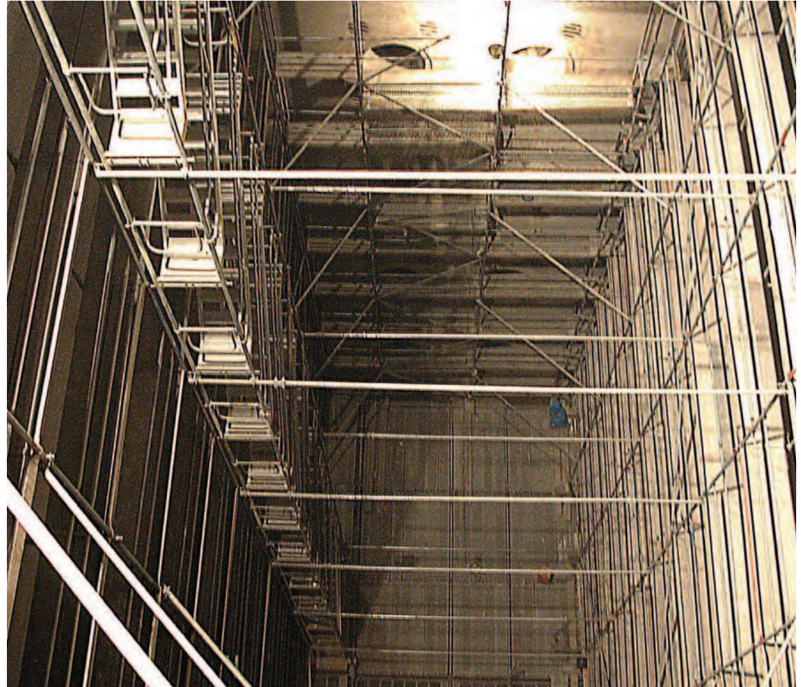
Spezialgerüste, wie hier ein Kesselgerüst, erfordern besonders viel Erfahrung und Knowhow
