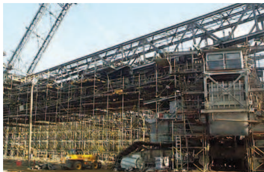
Krinis musste als Baustellenleiter viele individuelle Lösungen finden
